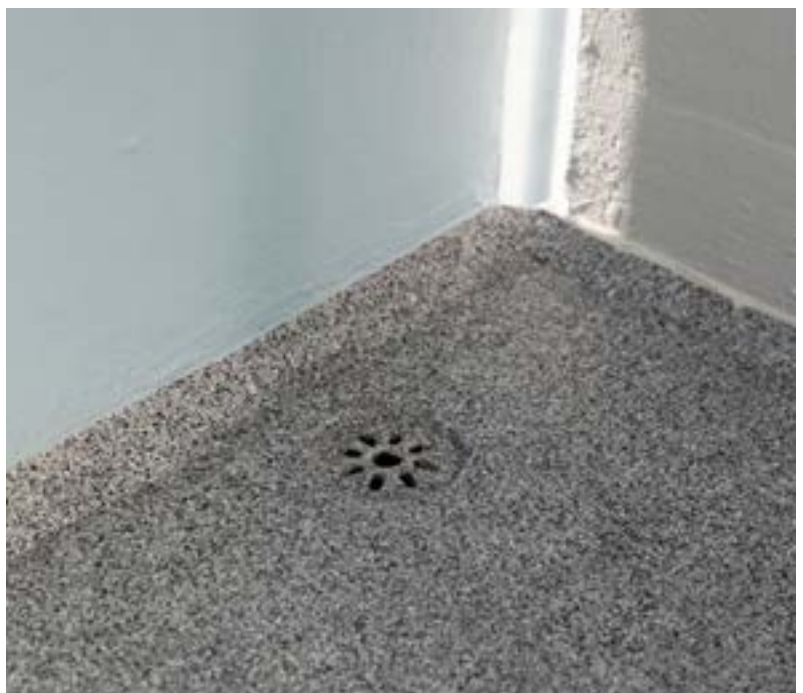
Bild oben: Wohngebäude St. Gundekar Werk, Ingolstadt, DE System: StoFloor Balcony Waterproof DL 300 Foto: Duckek
