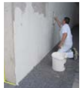
Schließen der Löcher und Lunker mit Egalisierspachtelung
