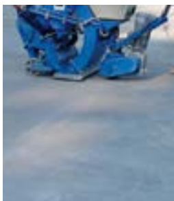
Untergrundvorbereitung Kugelstrahlen
