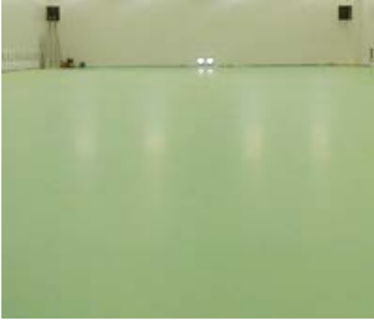
Beschichtungen auf Boden, Wand und Decke
