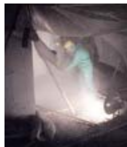
Untergrundvorbereitung Hochdruckwasserstrahlen
