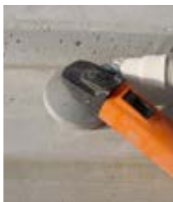
Untergrundvorbereitung Schleifen
