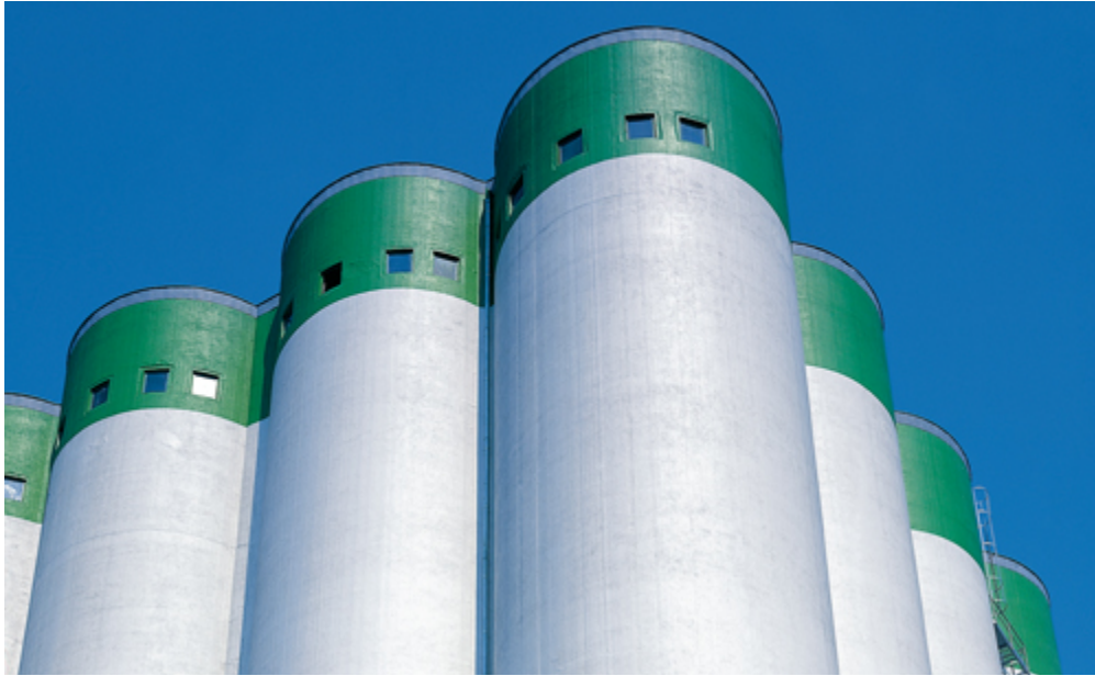
Silos Fürstenwalde, Foto: © StoCretec
