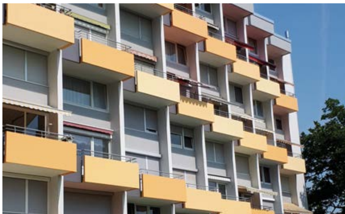
Wohnanlage Esslingen, DE StoCretec-Kompetenz: StoConcrete Protect V 700
