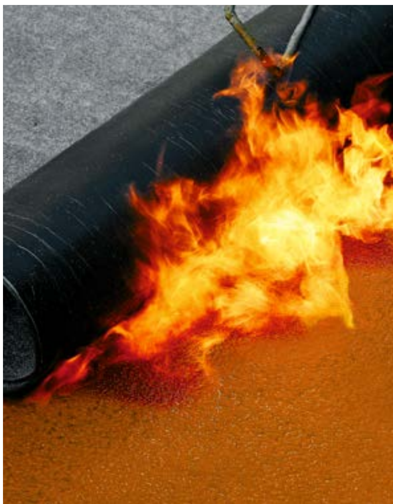
Brückenabdichtung mit StoPox BV 100 und Bitumenschweißbahn
