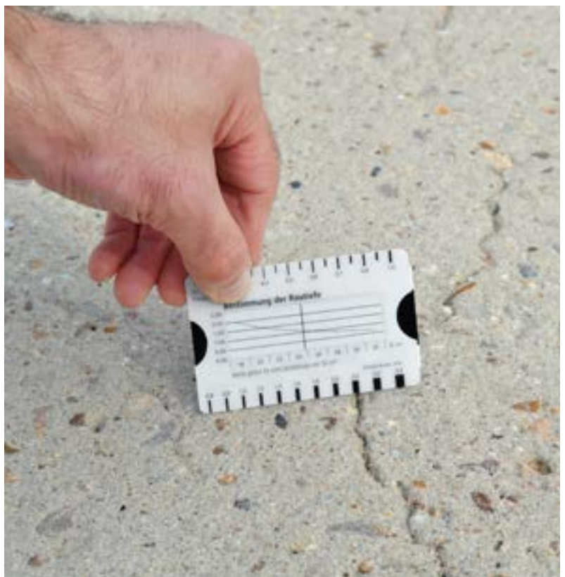
Injektionsharze dichten Risse ab und stellen so die Standsicherheit des Bauwerkes wieder her.
