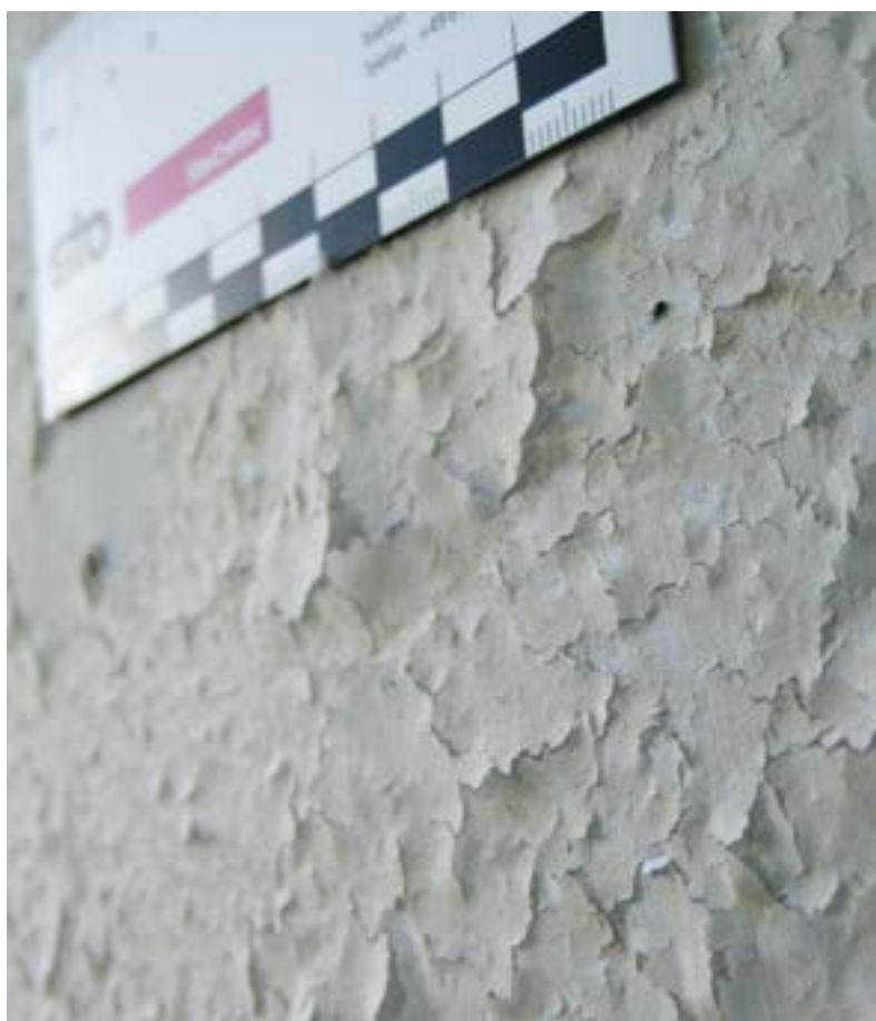
Sich lösendes Trägermaterial Bentonit nach Abschluss der Tiefenhydrophobierung mit StoCryl HG 200
