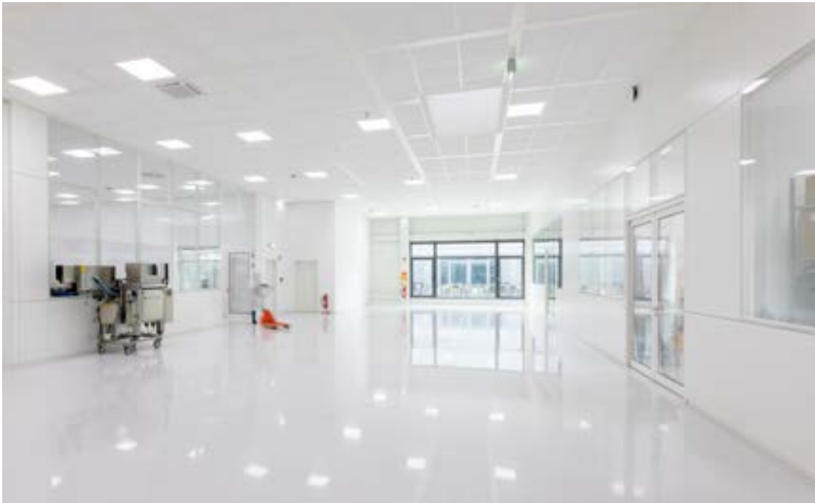
Neubau Produktion und Logistik, Eduard Gerlach GmbH, Lübbecke, DE StoCretec-Kompetenzen: StoFloor Cleanroom KU 601, StoFloor ESD KU 611 Foto: MT-Fotos
