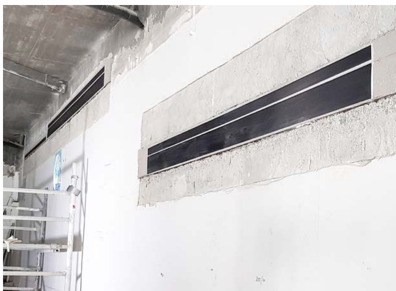
Kindertagesstätte, Offenbach, DE StoCretec-Kompetenzen: StoConcrete Carbon Plate, oberflächlich geklebt, StoPox Mörtel standfest
