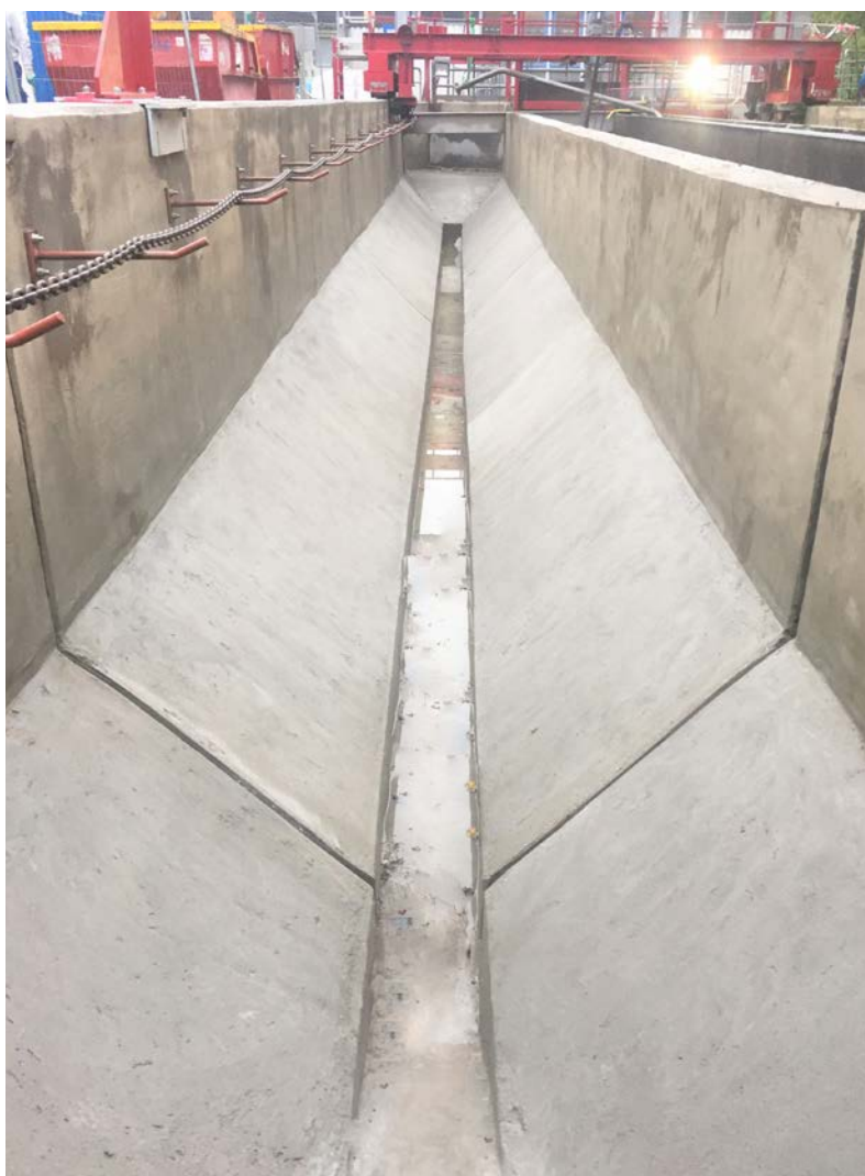
Sandfang, Kommunale Kläranlage, Bonn-Beuel, DE
